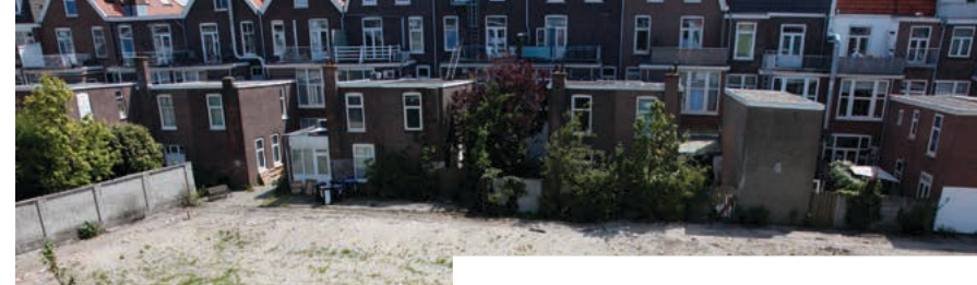
Inrichting Dakpark Rotterdam Totale projectkosten: € 5.680.000 Bijdrage KvW: € 2.014.457 Website: www.rotterdam.nl/dakpark
